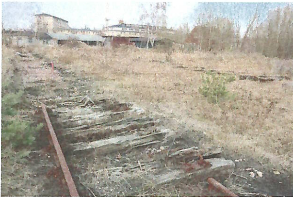
Gleisreste, Grundwassermessstelle, Waldbildung
