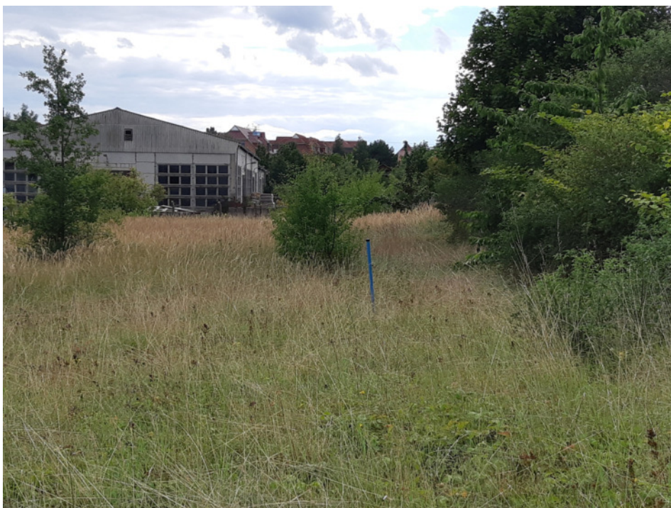
Bild 5 : Messstelle 1 Blickrichtung Westen
