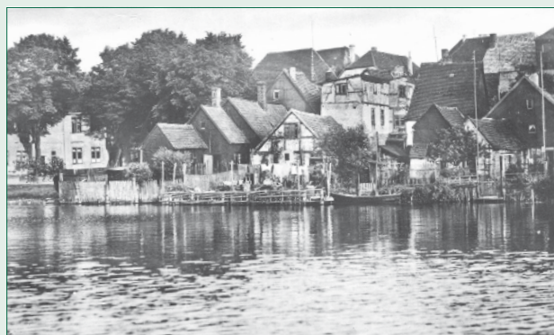
Große Mauerstraße, circa 1960
